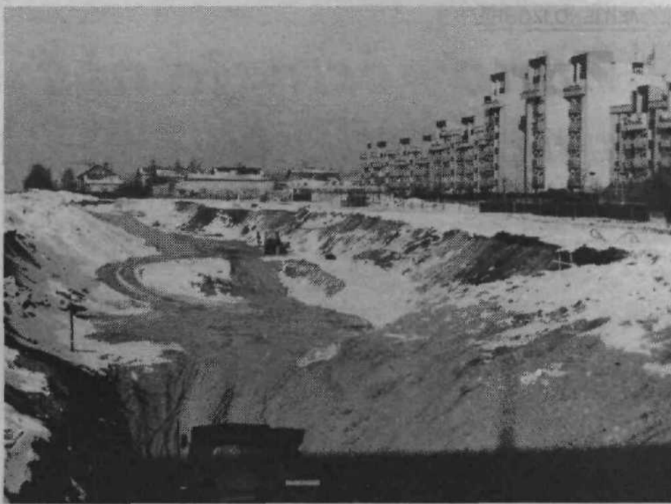
NA NAJVEČJEM GRADBISČU ZA BEŽIGRADOM
