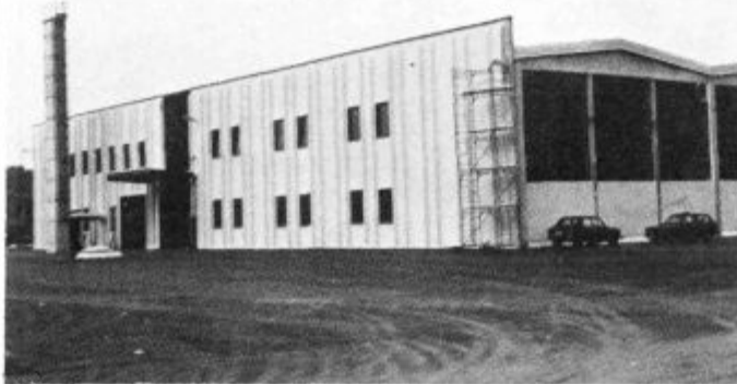
Pogled na del moderne hladilnice za sadje v Sp. Porčiču pri Lenartu
