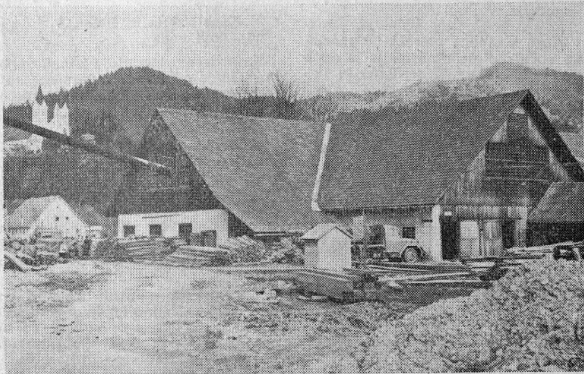
Le še nekaj dni in stara zgradba bo porušena (Foto: Pajk Franjo)
