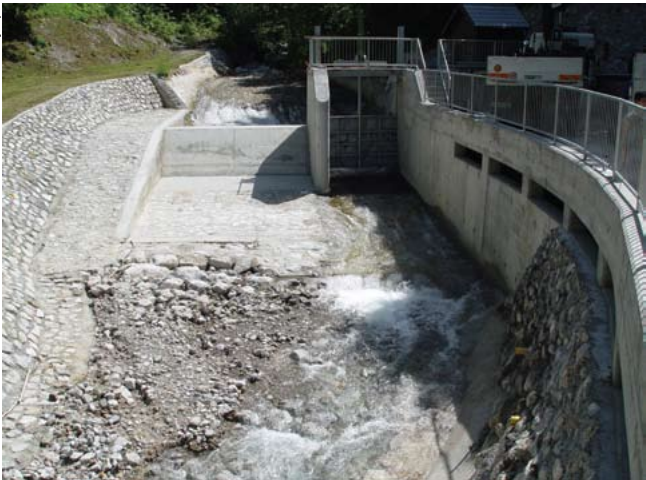
Sanacija hidroelektrarne Lomščica se je po letu dni uspešno končala.
