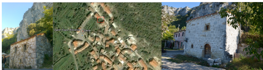
Slika 2: Podpeč, Zazid; obstoječa morfološka struktura kot potencial za oblikovanje sobnega bivalnega okolja.
