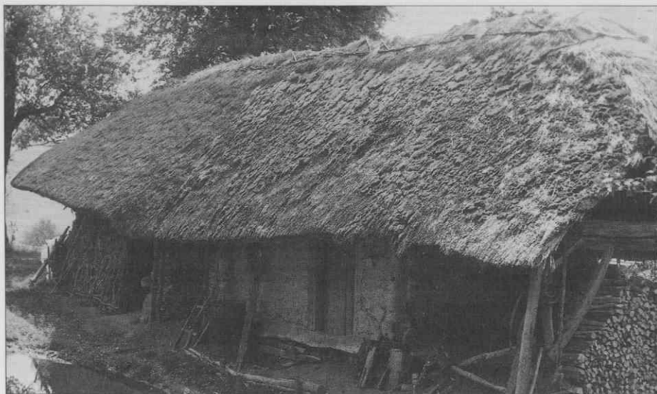
Sl. 3. Prvotno, samostojno in majhno gospodarsko poslopje, strukturirano in dimenzionirano po kmetijskih potrebah pred standardi, ki jih je oblikovala agrarno tehnična revolucija. Levo spodaj je viden del zalitega poznejšega gnojišča, ki sodi med nove standarde; pred njimi so bila na kmetijah gnojišča izjemna. ♦ The original, free-standing small outbuilding, structured and dimensioned according to the peasant's needs and to standards, developed by the agrarian technical revolution. In the left bottom we see part of the later dunghill, an element of the new standards; earlier, dunghills were very rare on farms. ♦ Premier bâtiment, petit et indépendant, présentait une structure et les dimensions conformes aux besoins du fermier - c'était avant l'application des nouvelles normes de la révolution agraire et technique. En bas, à gauche, on voit une partie de la fosse à fumier, recouverte, qui fait partie des nouvelles normes. Auparavant, les fosses à fumier à la campagne n'étaient qu'une exception.
