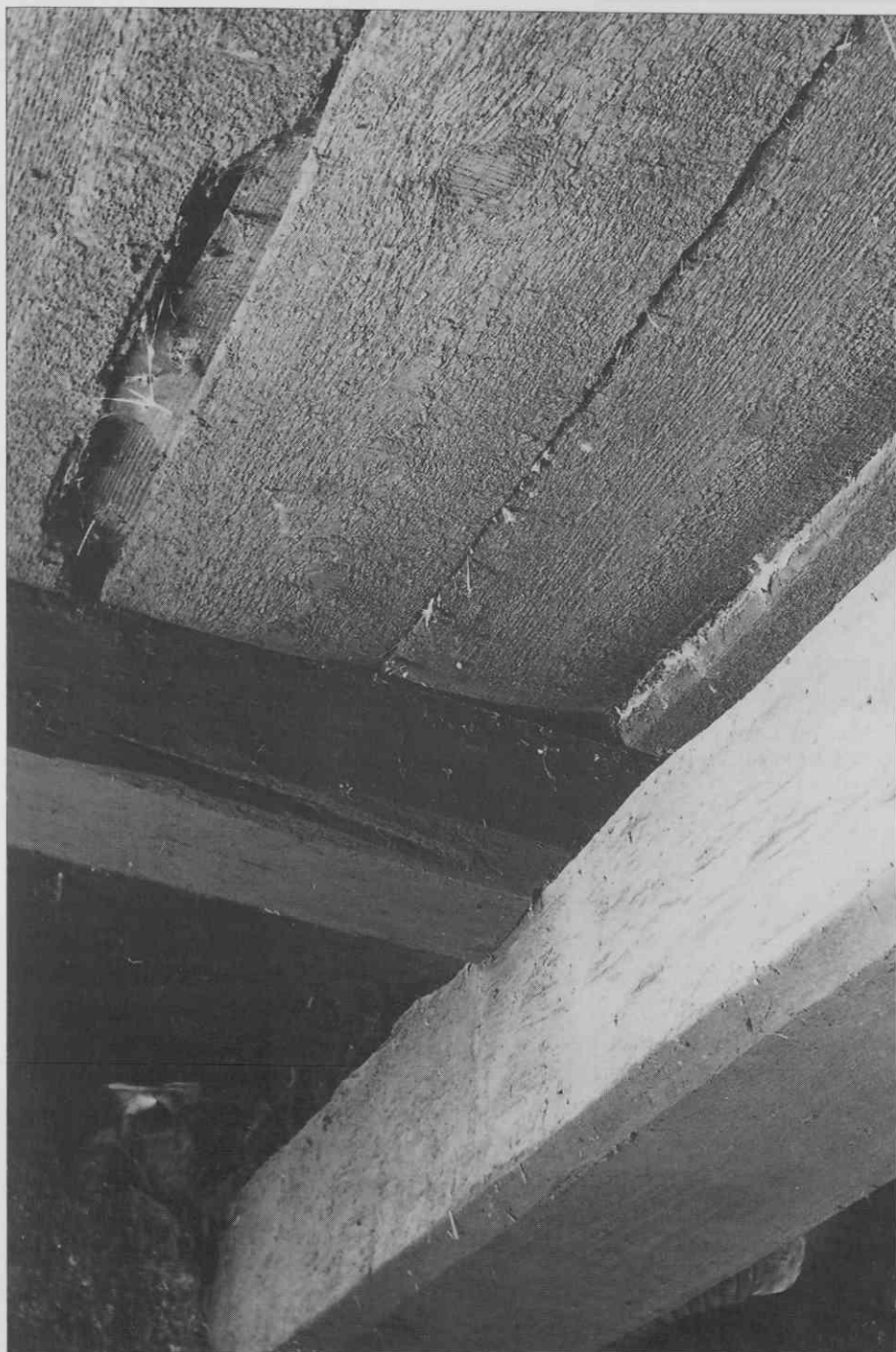
Sl. 10. Nadrobnost konstrukcije in obdelave stropa v velikem vhodnem, prvotno dimničnem prostoru. ♦ Detail of the construction and finishing of the ceiling in the big entrance room, originally the house's dimnica . ♦ Détails de construction et façonnage du plafond de la grande pièce d'entrée qui avant était enfumée.
