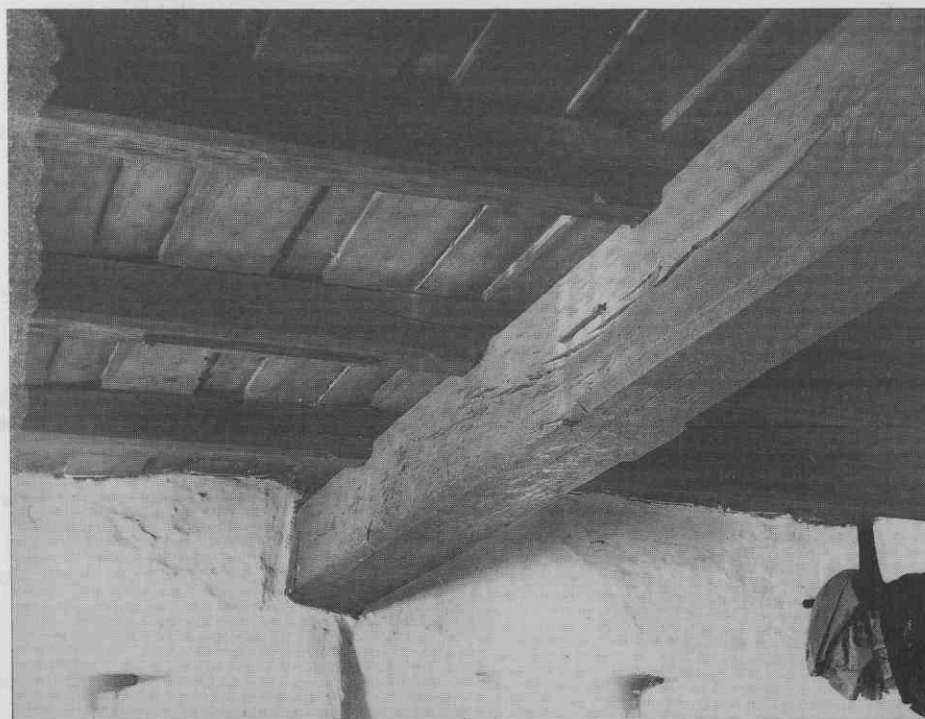
Sl. 11. Konstrukcija in obdelava stropa v izbi, prvotno neogrevanem stranskem prostoru. ♦ Construction and finishing of the ceiling in the izba , originally an unheated side room. ♦ Construction et façonnage du plafond de la chambre, pièce secondaire, autrefois non chauffée.
