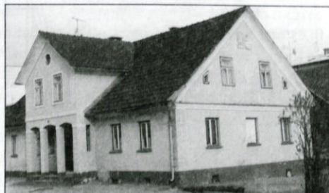
Sedanja podoba Karlingerjeve hiše v Ivančni Gorici. V njej je uradoval litijski okrajni glavar F. Podboj in odbor Skupne rokodelske zadruga.
