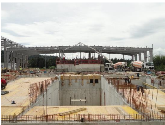
Slika 89: Gradnja Poslovno - proizvodno skladiščnega objekta Steris ter pogled na bunker, v katerem sta nameščena pospeševalnika (Foto: URSJV)
