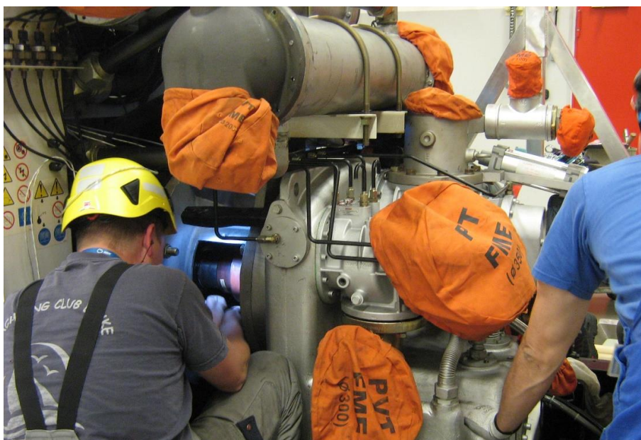
Slika 66: Servisna dela na kompresorju instrumentacijskega zraka (Foto: inšpekcija URSJV)
