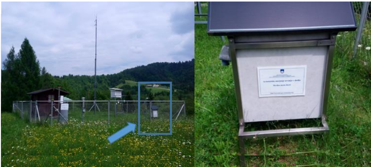
Slika 95: Prenosna postaja za meritve zunanjega sevanja na območju odlagališča Boršt
