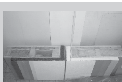
□ Slika 3. Element z instalacijsko ravnino
