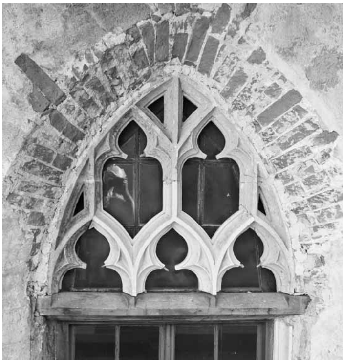
Slika 10: Ptuj, dominikanski samostan, krogovičje okna v severnem kraku križnega hodnika po čiščenju, ki je razkrilo obsežen restavratorski poseg iz 19. stoletja (Foto: Robert Peskar.)
