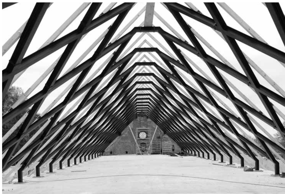
Slika 8: Ptuj, dominikanski samostan, nova kovinska strešna konstrukcija na AB-plošči ter statična rešitev čela vzhodne fasade (Foto: Robert Peskar.)
