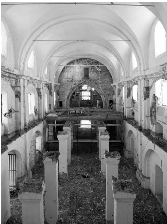
Slika 4: Ptuj, dominikanski samostan, pogled v notranjščino cerkve proti vzhodu med odstranjevanjem medetažne konstrukcije (Foto: Robert Peskar.)
