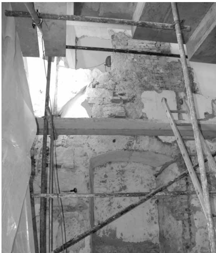
Slika 8: Slepо okno pred odstranitvijo gradbenega polnila (Foto: Vlasta Čobal Sedmak.)
