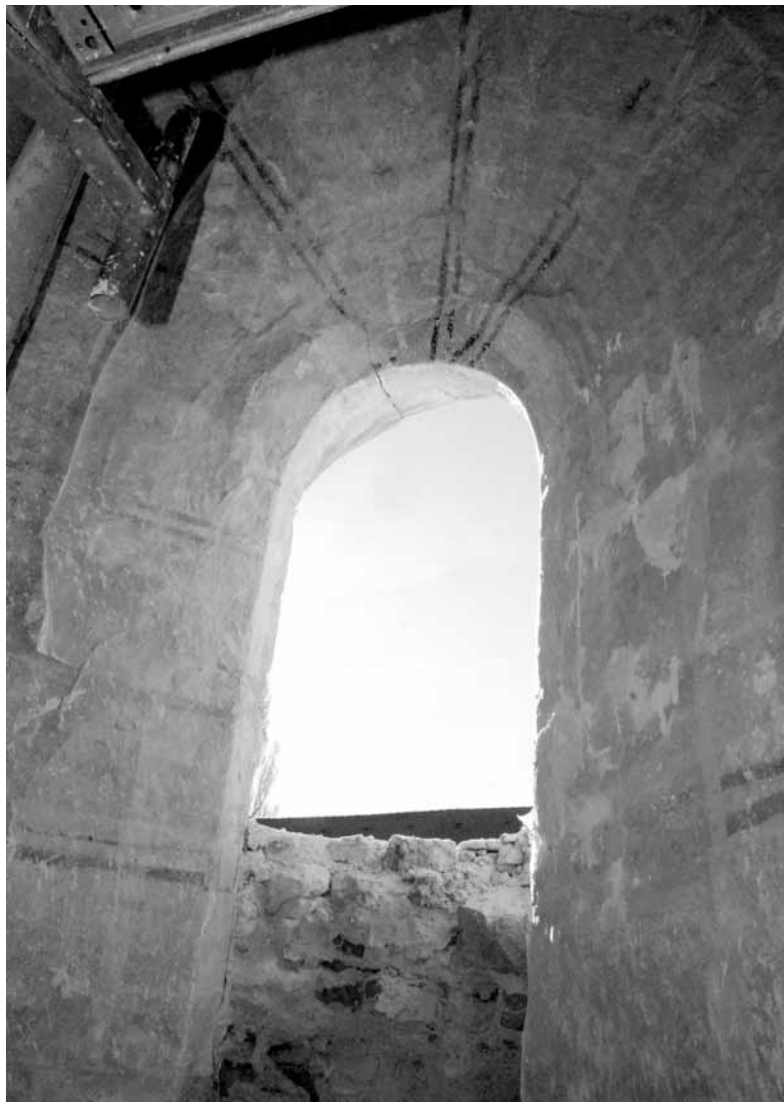
Slika 6: Zahodno romansko okno na južni cerkveni steni, preboj med obnovo (Foto: Vlasta Čobal Sedmak.)
