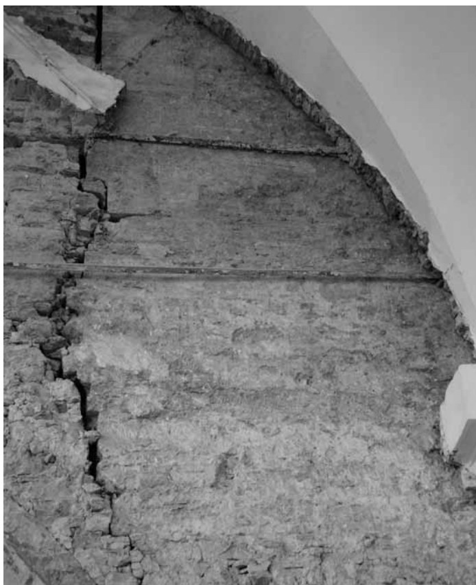
Slika 4: Slavoločna stena po odbijanju opečne obloge. Na sredini komaj vidna poslikava grba na originalnem ometu (Foto: Vlasta Čobal Sedmak.)
