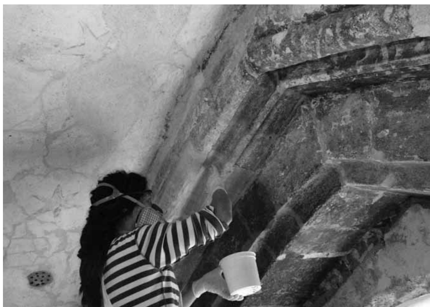
Slika 3. Poslikan kamniti slavoločni lok med postopkom čiščenja in utrjevanja s celulozno pulpo (Foto: Vlasta Čobal Sedmak.)
