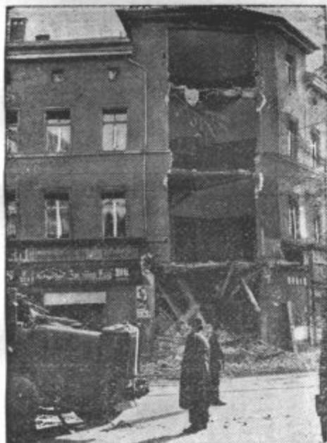
AVTO PORUŠIL HIŠNI VOGAL. V Berlinu-Weissensee se je primerila neobičajna prometna nezgoda. Neki tovorni avtomobil se je na ovinku ulice s takšno silo zaletel v vogalno hišo, da se je zrušil zunanji zid od temeljev do vrha. K sreči ni bilo človeških žrtev.
