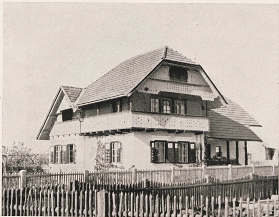
Slika 161. Nova hiša v gorenjskem slogu pri Domžalah. (Zgradil tesarski mojster Franc Ravnikar. Fotografiral Jože Karlošek.)
