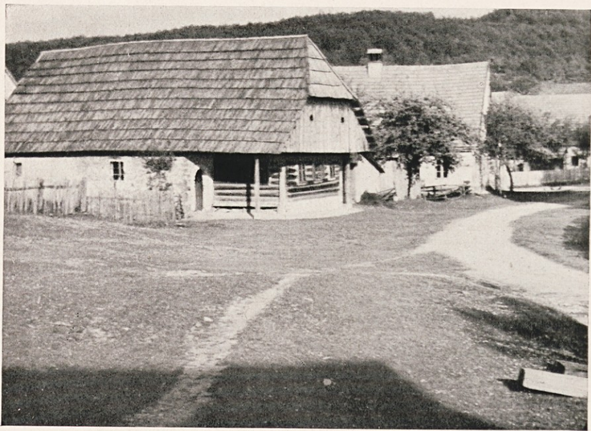
Slika 119. Kočevska hiša v Štalcerjih. (Po »Kočevskem zborniku«.)
