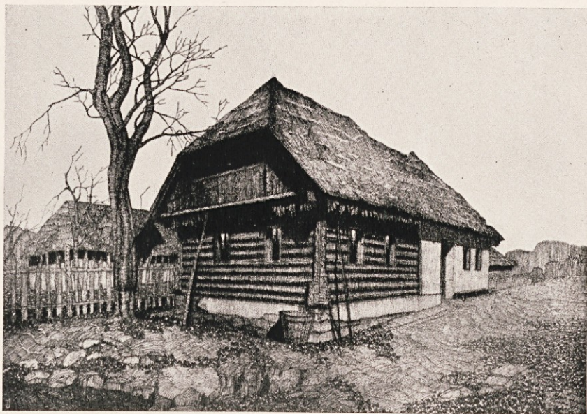
Slika 104. Deloma lesena, deloma zidana hiša v Vojni vasi pri Črnomlju. (Narisal inž. arh. Rado Kregar.)
