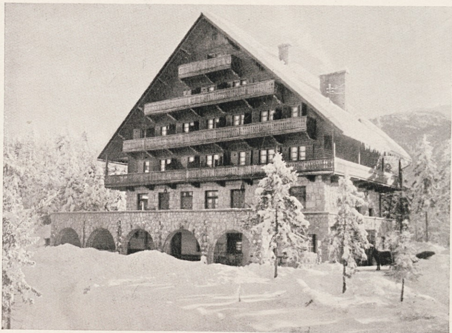
Slika 155. Hotel »Bellevue« pri Bohinjskem jezeru. (Projektiral inž. arh. L. Kham. Fotografiral J. Ravnik.)
