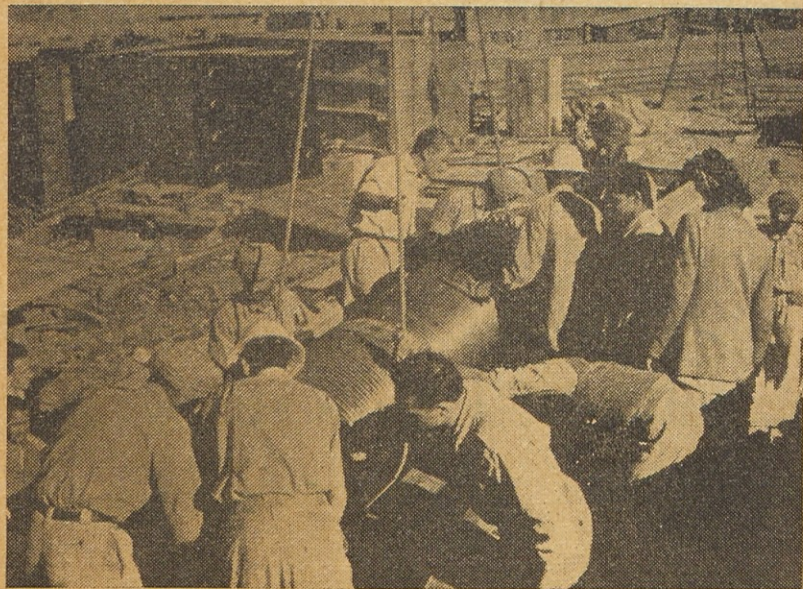
Naši inženirji in tehniki nadzirajo montažo doslej največjega električnega mostnega tekalnega žerjava za dviganje bremen 460 t, ki ga je Litostroj izdelal za Indijsko hidrocentralo BHAKRA NANGAL pod Himalajo
