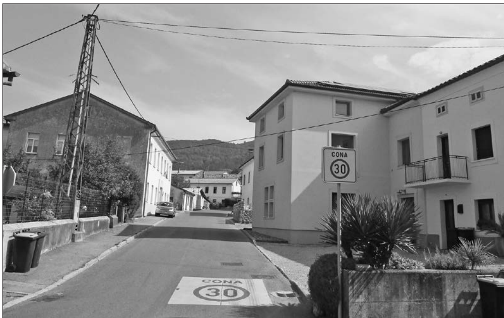
Gorenec, zgornji del Trnovega, danes Jurčičeva ulica; na desni zgradba stare šole, kjer je Gerbič poučeval v letih 1857–1864, levo nova šola, odprta leta 1866, od katere se je poslovil spomladi 1868 (foto: B. Golec, avgust 2023).
