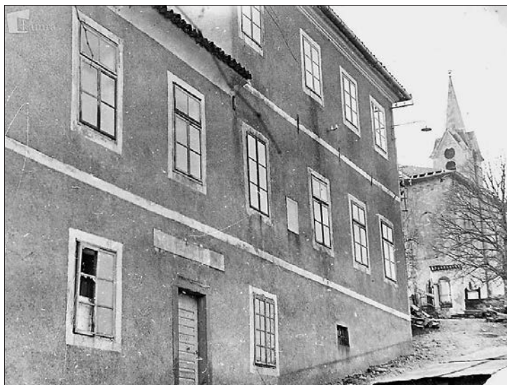
Stavba nekdanje premske osnovne šole leta 1965. Od leta 1968 je v njej urejena Kettejeva spominska soba (Vojko Čeligoj, spletni portal Kamra).
