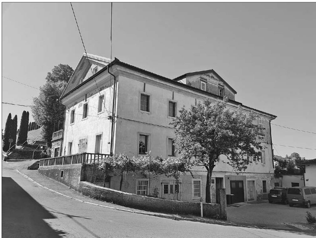
T. i. Jenkova hiša na lokaciji nekdanjega dvorca – Jurčičeva ulica 18 (foto: Viljem Gombač, avgust 2023).
