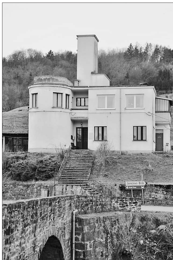
Prem – nekdanja občinska stavba, danes zapuščena (foto: Emilija Kastelic, 2015).
