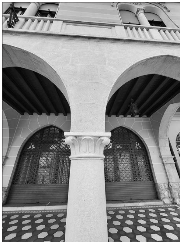
Iz umetnega kamna so bili zelo kvalitetno izdelani vsi predvideni elementi, tudi stebri arkadnih hodnikov (foto: Eda Belingar, 2023).
