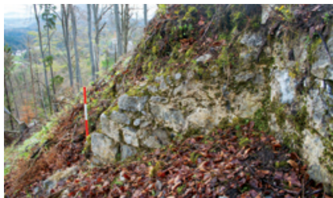
Sl. 3.1.11: Kašča. T2. Kot v severnem obzidju in severozahodni vogal stolpa. Pogled proti vzhodu (foto: A. Gaspari).
