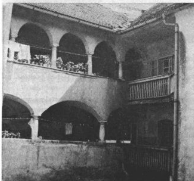
TOMŠIČEV TRG 6 — primer oblikovanega re- nesančnega arkadnega dvorišča
