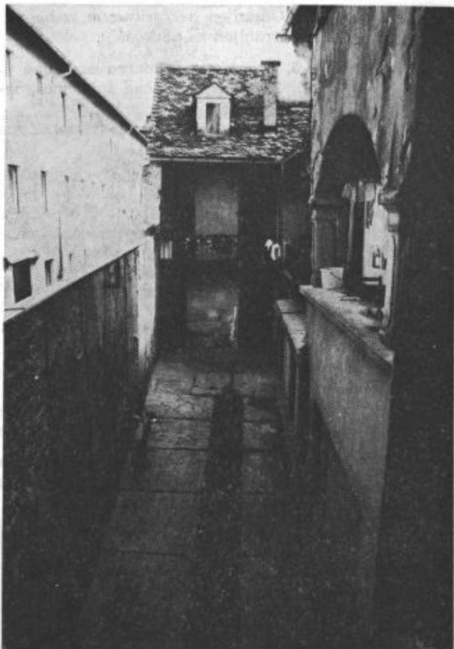
TOMŠIČEV TRG 4 — značilni tip ozkega zaprtega dvorišča z arkadnim veznim traktom, požarnim zidom ter sklepnim dvoriščnim traktom
