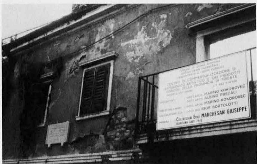
Končno so začeli graditi pogorelo rojstno hišo Iga Grudna v Nabrežini
