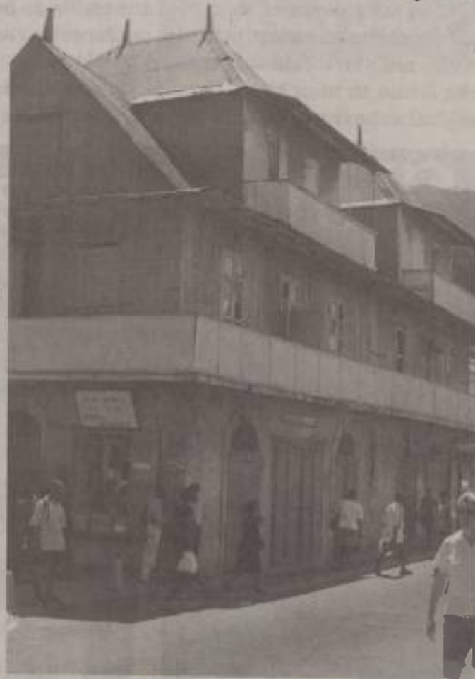
Revnejše mestne hiše iz kolonialnih časov se močno razlikujejo od belih vil na plantažah; večji del je zgrajen iz pločevine. Vendar pa se posebnih vremenskih nevšečnosti ni bati. Sodobne hiše običajno sploh nimajo oken, temveč le nekakšne steklene premične žaluzije, skozi katere lahko zapiha osvežujoč veter.
