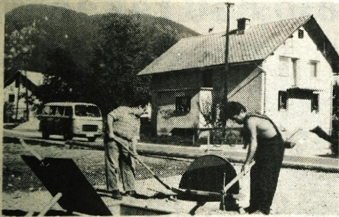
ZAPUŽE — S prostovoljnim delom ter deloma s prispevkom Alpdoma in interesne skupnosti za požarno varnost Radovljice so v Zapužah zgradili nov požarnovarnostni bazen. — Foto: F. Perdan
