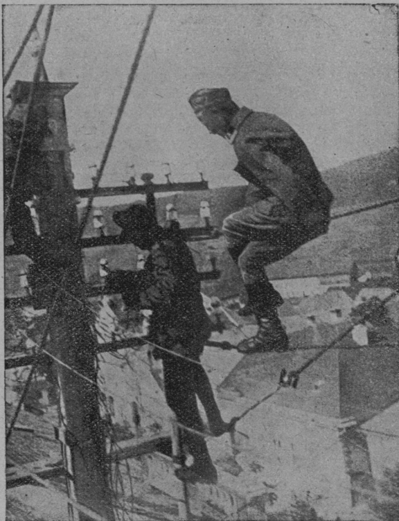
Telegrafski vojaki popravljajo kabel. Na tronti imajo mesto žic le kabel za telegrafske zveze.
