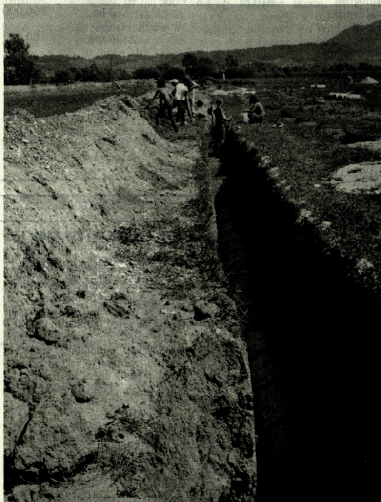
Delo brigadirjev je rodilo sadove. V Bistrici ob Sotli je zgrajen nov kolektor.
