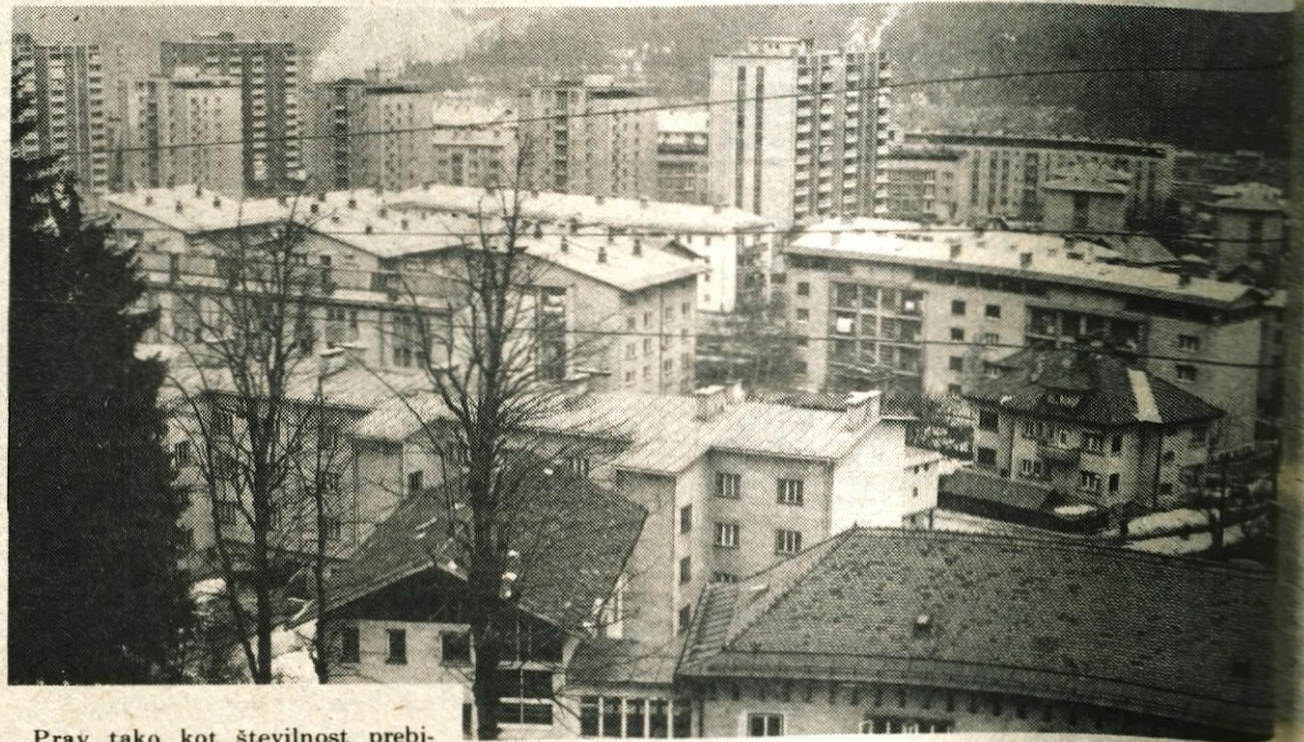
Pogled na osrednji del Plavža
