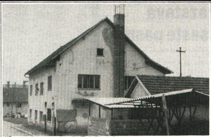
Propadajoča zgradba Rašice Horjul
