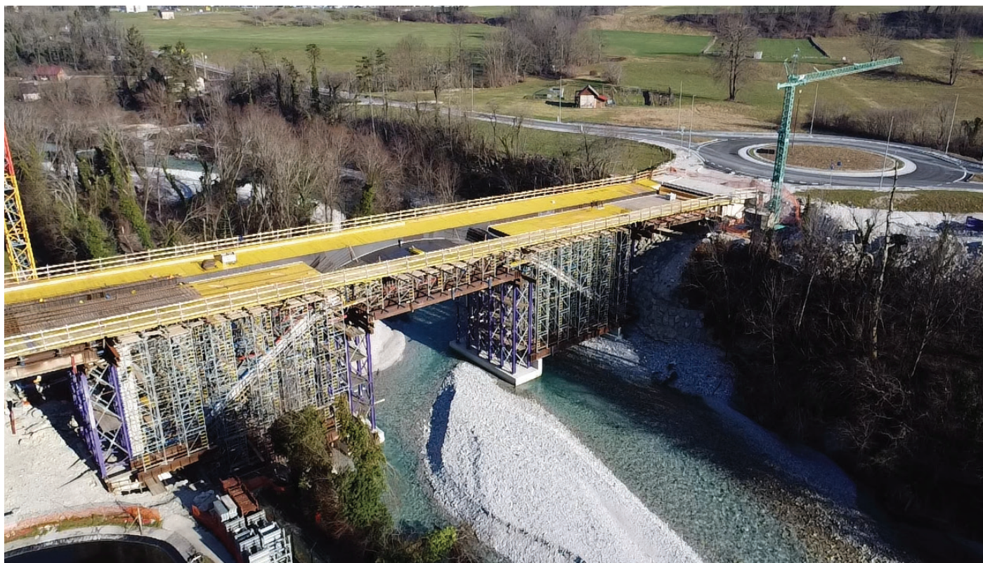
Slika 7. Most čez Tolminko in krožno križišče K4.
