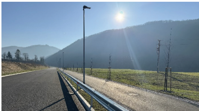
Slika 10. Izvedena JVO in javna razsvetljava med obvoznico ter površino za pešce in kolesarje z novo posajenim drevoredom v ozadju.
