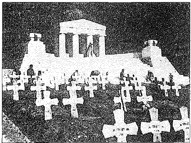
Štanjel, vojaško pokopališče padlih v 1. svetovni vojni. Zaključna dela na pokopališču leta 1917 - dokumentacija ZVNKD Gorica (preslikava).
