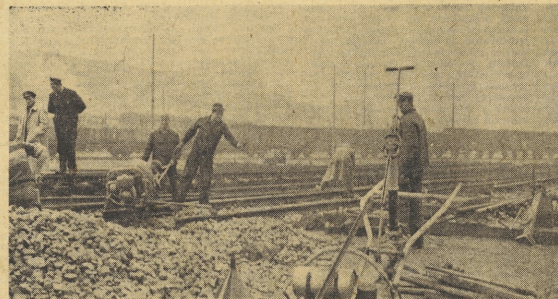
Tudi železniški progam zima ni povsem prizanesla, toda progovni delavci so v najkrajšem času popravili nastalo škodo in usposobili proge
