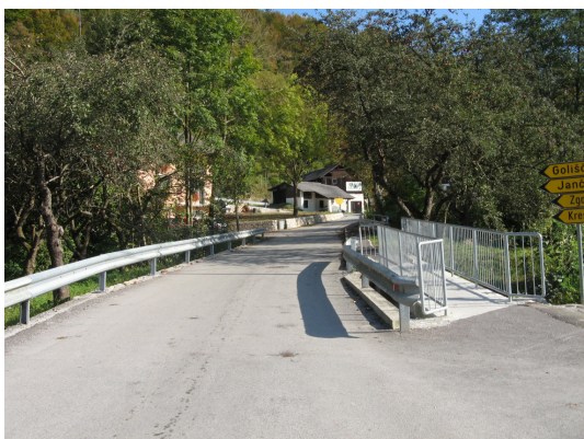
Fotografija 14: Rekonstrukcija mostu (Jevnica)
