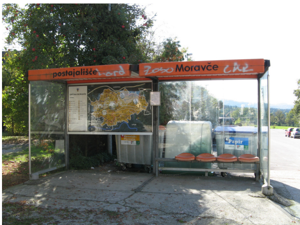
Fotografija 22, 23: Čakalnica postajališča javnega prometa, ob njej je umeščen ekološki otok Photo 22, 23: Bus stop and refuse collection for recycle beside it
