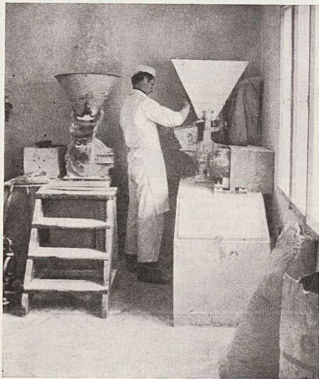
Mlina za mletje sladkorja za čokolado, v suhem in svetlem prostoru
