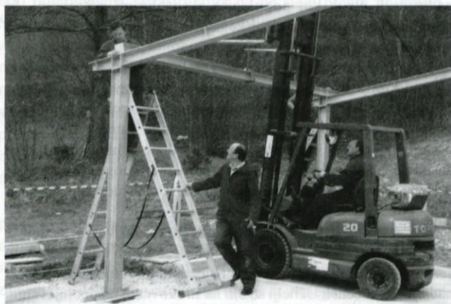
Montaža parkirišne strehe.
