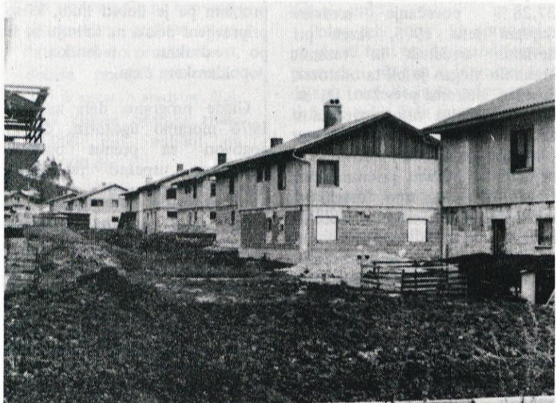
Montažno naselje v Dragomerju dobiva iz dneva v dan lepšo podobo, saj so prvi stanovalci že vseljeni, do konca letošnjega leta pa se jih namerava vseliti še velika večina. Kot so nam povedali tisti, ki tu že stanujejo, so zadovoljni, moti jih le slaba voda in komunalne usluge – zlasti odvoz smeti in še neurejene poti in ulice.
