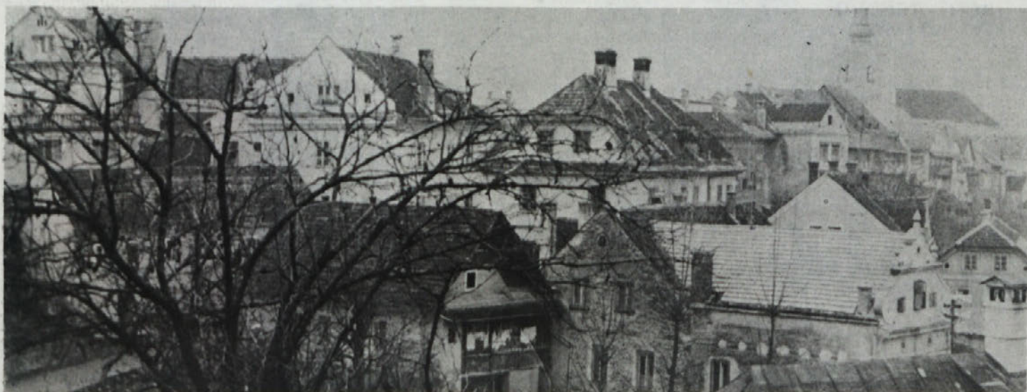
Stari del Metlike ostaja neizpremenjen in ga čuvamo kot zgodovinsko znamenitost, medtem pa na vseh obronkih mesta rasto nove hiše, cela naselja. Trenutno gradijo blizu tovarne BETI doslej največji stanovanjski blok, v katerem bo tudi prvo metliško dvigalo.
