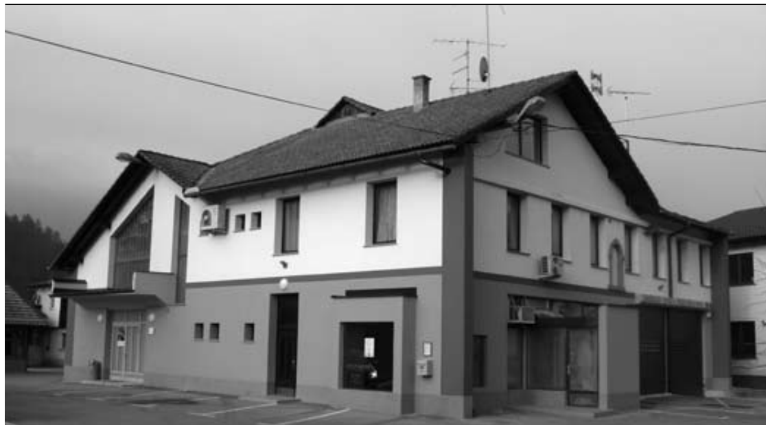
Nova fasada kulturne dvorane in gasilskega doma v Iški vasi
