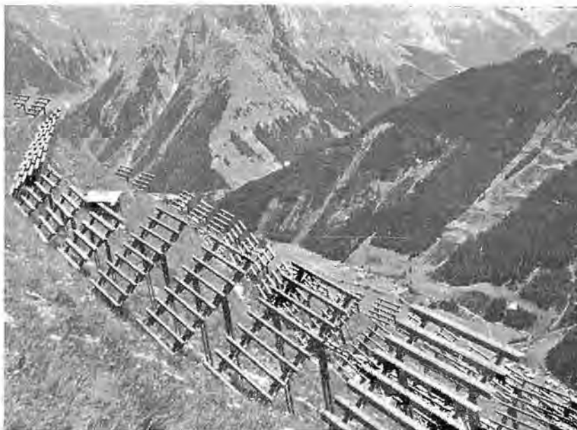
Na Heubergu nad 700 objektov iz jekla z betonskimi temelji varuje cesto in naselje Häselgehr pred snežnimi plazovi. (Orig.)
