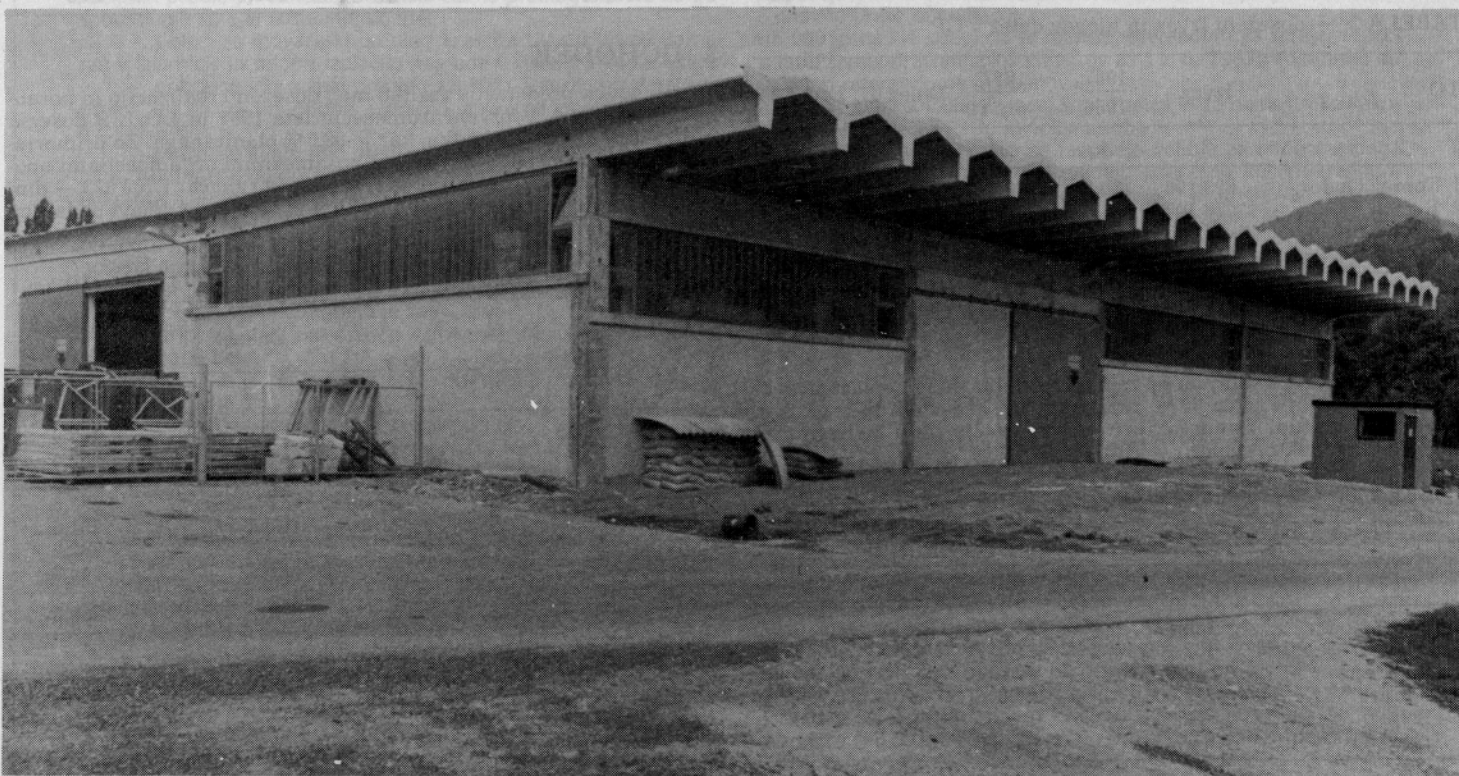
Novozgrajena hala za proizvodnjo I nosilcev; proizvodnja bo stekla v drugi polovici leta 1987
