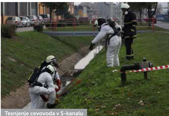
Tesnjenje cevovoda v S-kanalu
