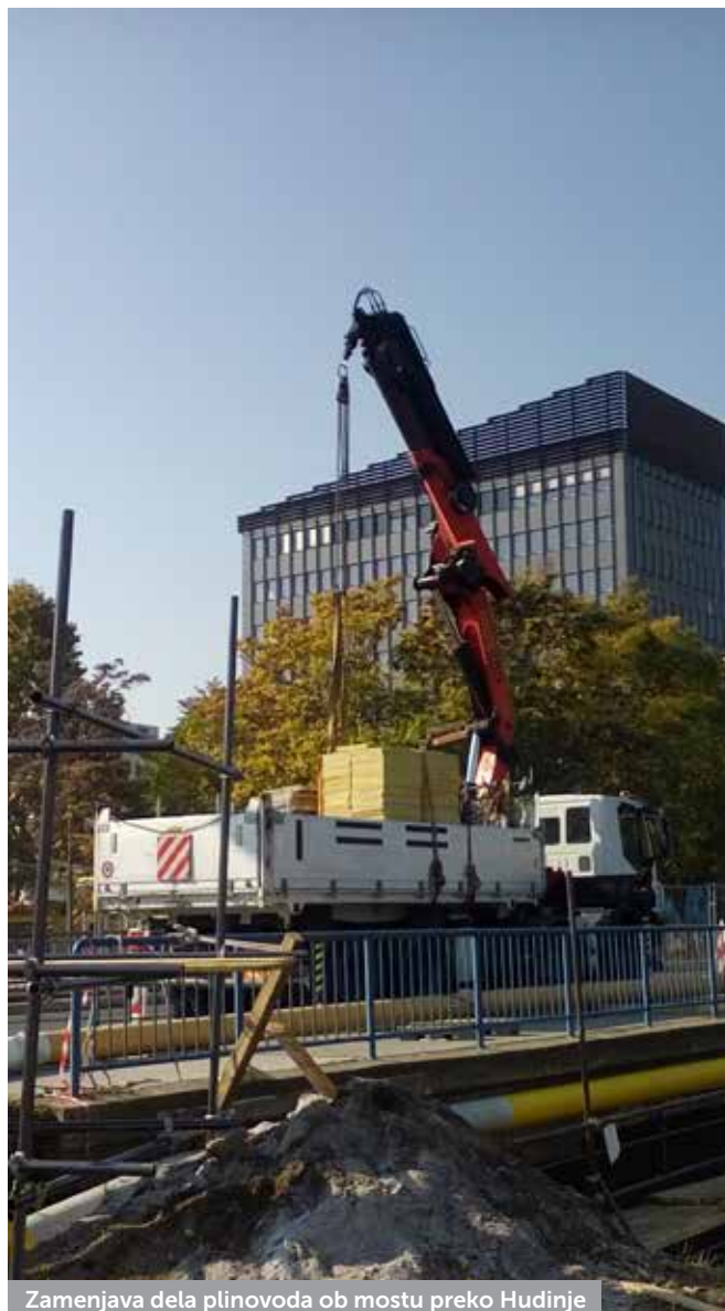
Zamenjava dela plinovoda ob mostu preko Hudinje
