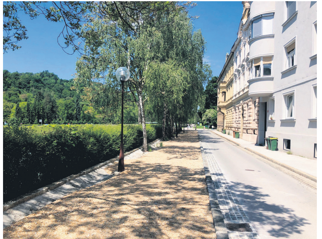
Gradnja kolesarske steze na Savinjskem nabrežju
