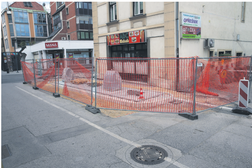
Nova podzemna zbiralnica odpadkov na križišču Stanetove in Miklošičeve ulice (Foto: Andraž Purg – GrupA)
