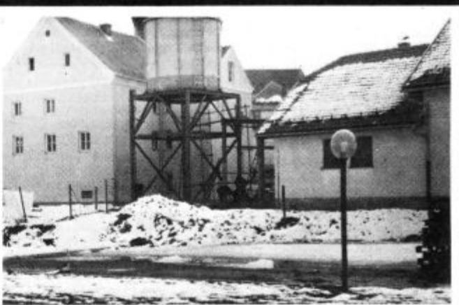
Bolj po poljže poteka izgradnja skladišča trgovine KZ v občinskem središču
