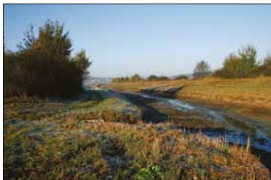
Dodatek – slika 6: Dovodni kanal zadrževalnika Medvedce (foto: D. Bordjan)
