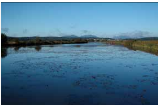
Dodatek – slika 8: Notranji kanal zadrževalnika Medvedce (foto: D. Bordjan)
