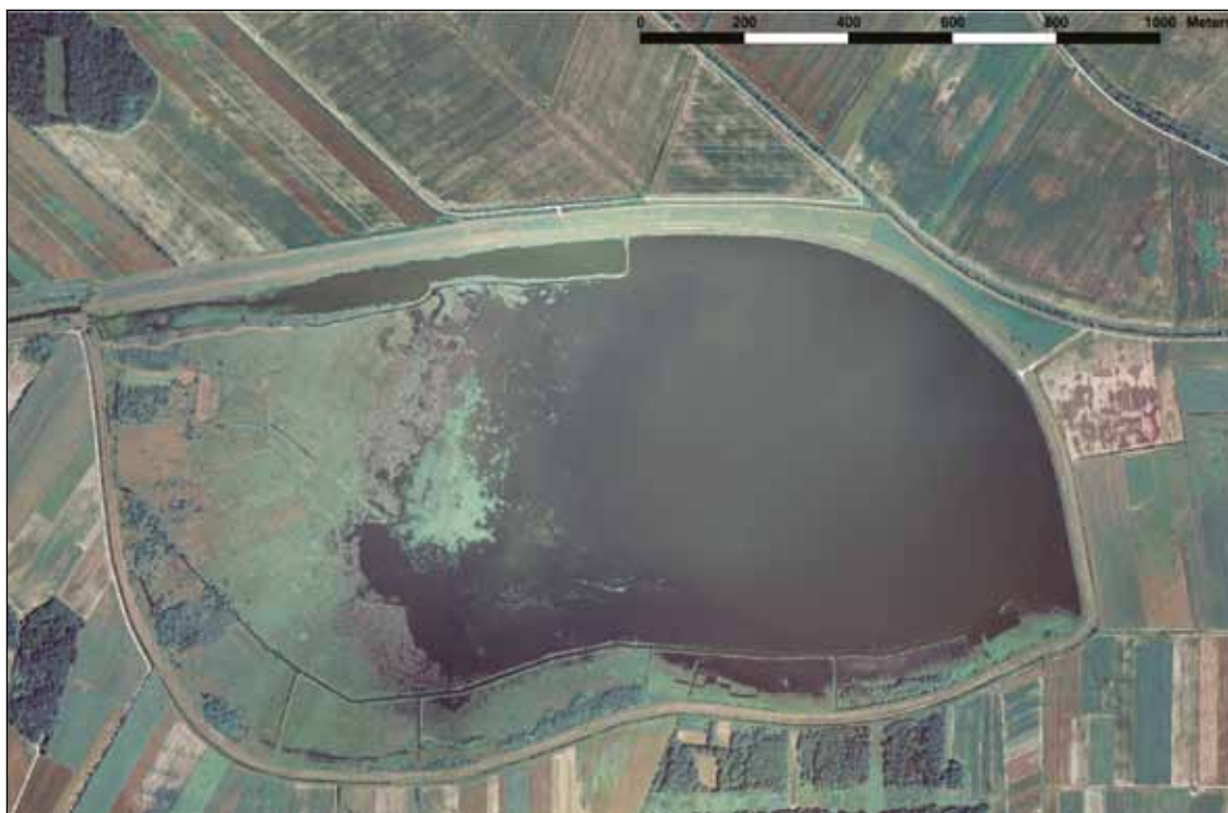
Slika 2: Ortofoto zadrževalnika Medvedce, julij 2006 (© Geodetska uprava Republike Slovenije). Zadrževalnik obdaja visokovodni nasip, vodni in kopenski del zadrževalnika sta ločena s 50–200 m širokim pasom rogoza Typha sp. in navadnega trsta Phragmites australis . Na SZ vogalu se v zadrževalnik steka dovodni kanal, ki se nadaljuje v širši notranji kanal. V začetnem delu notranjega kanala in ob zahodnem robu odprte vodne površine je viden pas zakoreninjenih plavajočih makrofitov. Vzdolž severnega in vzhodnega roba zadrževalnika se na zunanji strani nasipa raztezajo občasno poplavljeni travniki.
