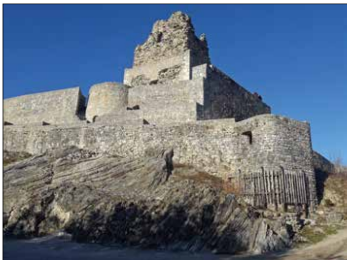
Temelji Smledniškega gradu
