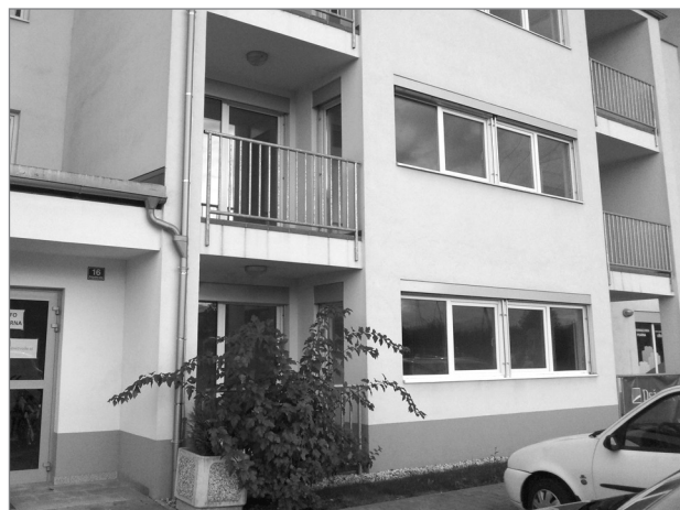
Slika 7: Pritlično stanovanje tik ob parkirišču in ob vhodu v stanovanjski objekt soseske Medvode (foto: B. Železnik Bizjak)
