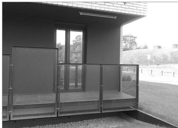
Slika 1: Soseska Zeleni gaj, Brdo, Ljubljana – izpostavljeno vogalno pritlično stanovanje; balkon je tik nad terenom, ograja je prosojna, na okna so dodane le temne tekstilne navojnice (foto: B. Železnik Bizjak).
