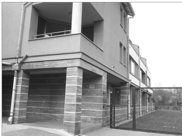
Slika 6: Pritlična stanovanja v poslovno-stanovanjskem objektu ob Podutiški cesti v Ljubljani (foto: B. Železnik Bizjak)
