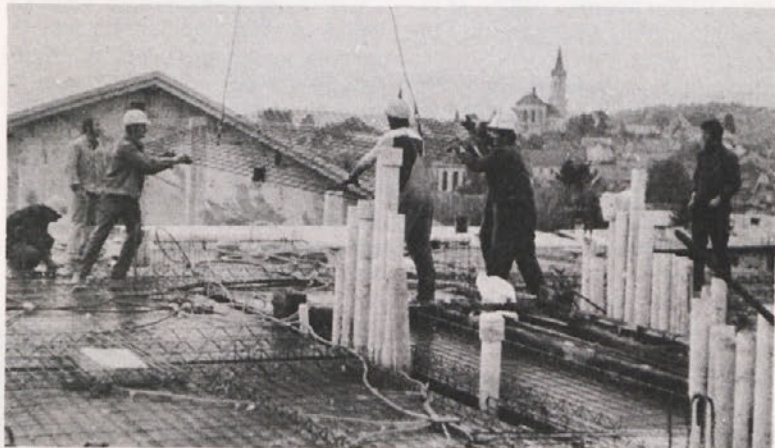
Železokrivci polagajo na vrhni del tunelskega opaža Outinord armaturo
