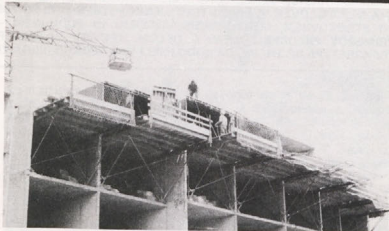
Gradnja stanovanj po sistemu Outinord se odvija zelo hitro: velik stanovanjski blok je v 4 mesecih od začetka del vseljiv
