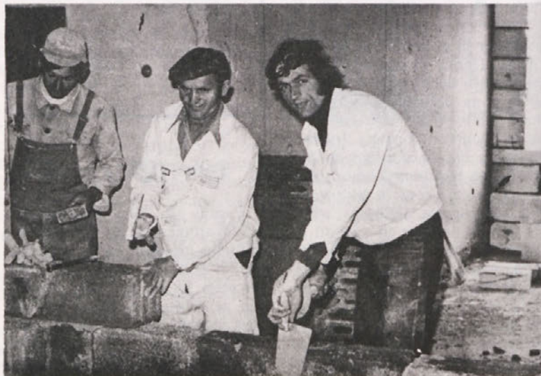
Med tem ko drugi še postavljajo dve nadstropji višje tunnelske opaže Outinord za gradnjo gornjih etaž, v spodnjih že zidarji zidajo vmesne stene iz betonskih zidakov ali iz siporexa
