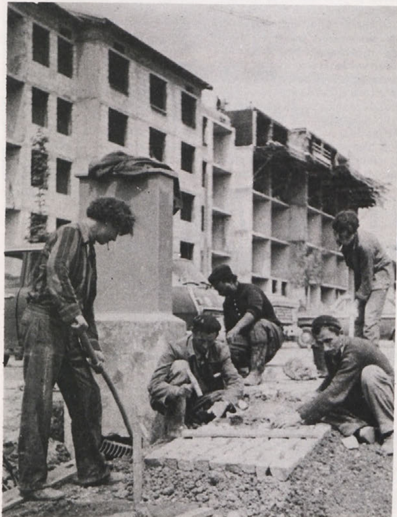
Hkrati z gradnjo novih stanovanjskih blokov na Ragovski v Novem mestu teče tudi komunalno urejanje, gradnja dostopov, peš poti in asfaltiranje
