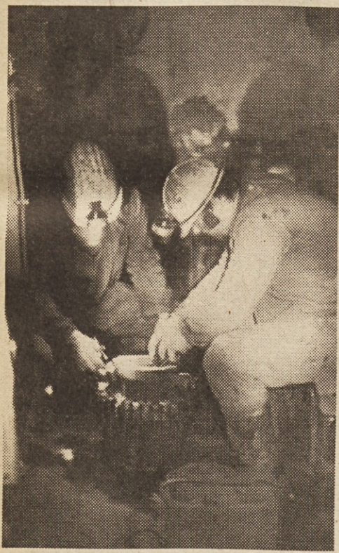
Elektrikarja Mirko Klepec in Janez Barič v osušenem delu jame že montirata transformatorje in elektromotorje
