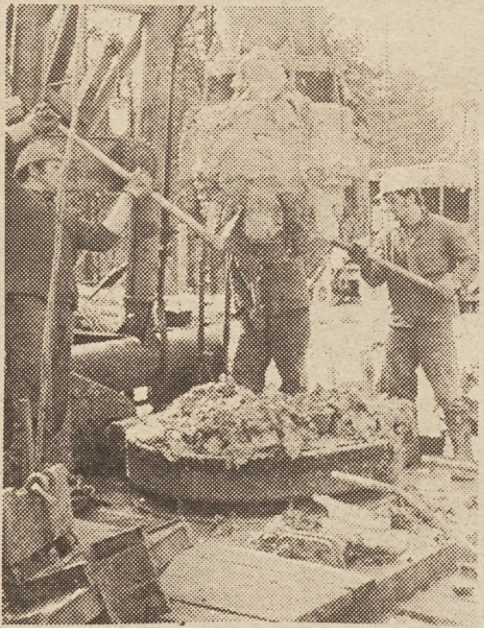
Vrtalci geodetskega zavoda so pri vrtnanju vodnjaka prišli sto metrov pod površino. Čaka jih še 150 metrov težkega in zamudnega dela
