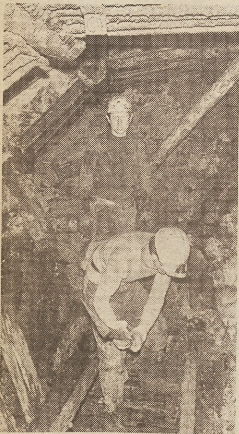
Tam, kjer je voda odtekla, že delajo rudarji. Franjo Kovačič in Harum Verbič čistita zrušek. Koliko je takih poškodb rogov, še ne vedo, vendar jih sproti usposabljaajo.
