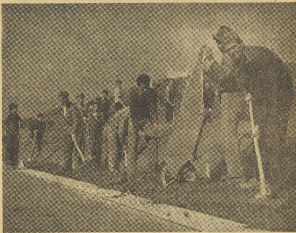
Avtomobilska cesta Bratstva in enotnosti je gradilo letos 466 mladinskih delovnih brigad, v katerih je bilo 53.430 mladincev in mladink. Zgradili so 28 kilometrov betonskega in 52 kilometrov asfaltnega cestišča. Na cesti je zgrajenih 52 raznih objektov, med katerimi sta dva največja most pri Jankomirju, dolg 330 m, ter 119 m dolg nadvoz pri Trebnjem. Zadnji mesec so urejali še okoliščine ceste ter odpravljali stroje, barake, opremo itd. na cesti Parožin-Niš, kjer bo naslednje leto novo bojno polje mladinskih brigad. — Na sliki so mladinci iz 18. čr-gorske, dvakrat udarne in enkrat posebej pohvaljene brigade iz naselja Lukovk.
