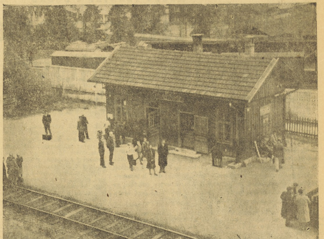
V Ravnah na Koroškem ljudje že dolgo čakajo na novo postajno poslopje. Blizu se obdobje slabega vremena in zdaj bo vsak dan tudi po 300 delavcev čakalo kar na prostem prihoda vlaka, saj majhna čakalnica ne more sprejeti vseh pod streho.
