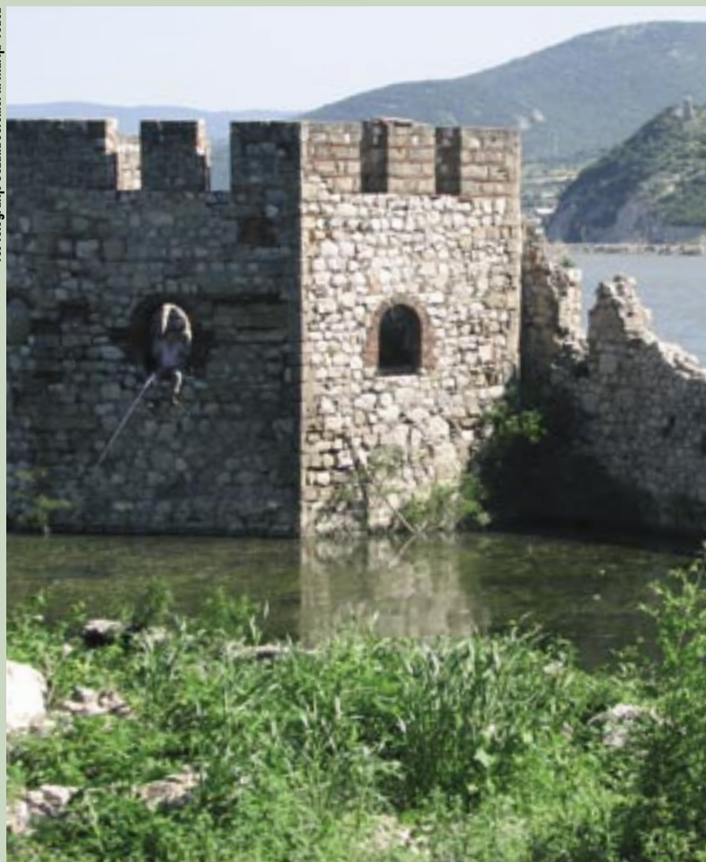
Poplavljeni obrambni stolp trdnjave Golubac je lahko odlično mesto za ribarjenje.
