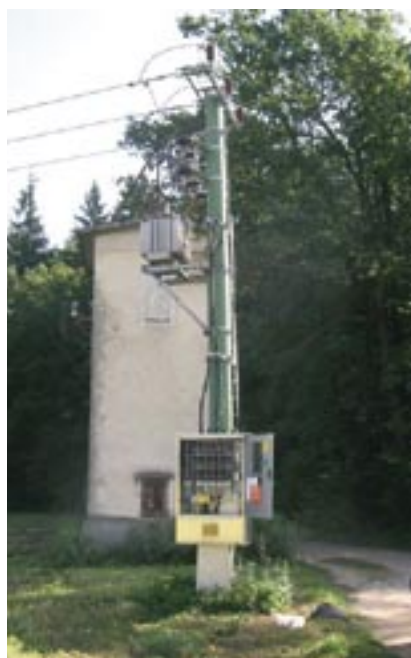
Sistem, nameščen v NNR transformatorske postaje
