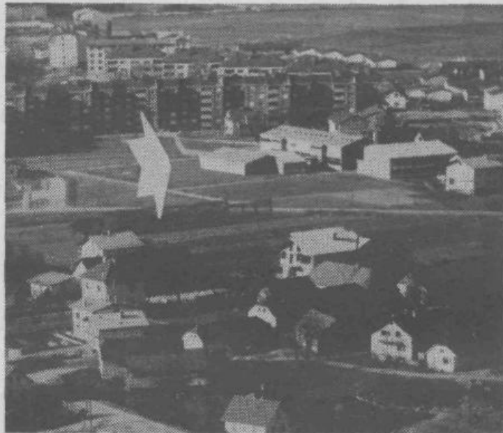
Osnovna šola Adolfa Jakhla v Zalogu je bila prva v Ljubljani zgrajena s sredstvi iz samoprispevka. Žal je že danes premajhna. Da bi lahko zagotovili enoinpolizemski pouk, je potrebno zgraditi prizidek s štirimi učilnicami. Predvidena investicijska vrednost je 6.000.000 dinarjev
