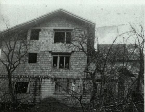
Gradnja nove hiše pri Krtu. Na desni je viden del stare hiše. Iz okna v novi hiši gledajo iz leve: Danilo, mama Fanika in Jožica Jevšnik.
