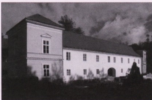
Zgradba Koroške osrednje knjižnica med prenovo ...
