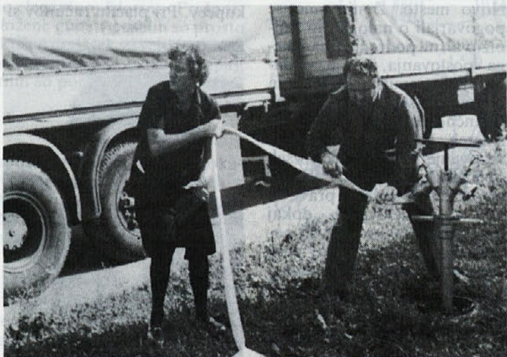
Hidrant je bil čez cesto, ogenj pa je izbruhnil na zadnji strani stavbe. Ni bilo časa za preoblačenje, napeljati je bilo treba cevi in čimprej začeti z gašenjem.
