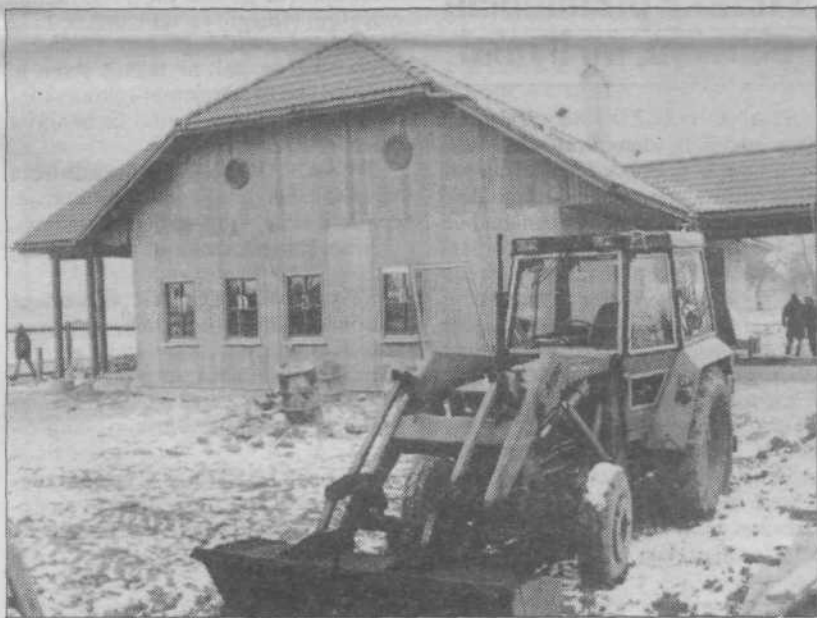
NOVA POŠTNA STAVBA V ZADVORU Zadvorcem in okoličanom bo v prihodnje še lepše. Poleg Zadrufnega doma postavljajo lepo montažno hišo v kateri bo nova pošta.
