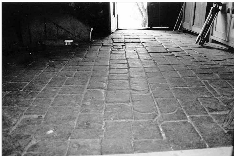
Veža, tlakovana z lesenimi čoki v Kumprejevi hiši na Primožu. Tam je ohranjena tudi izredno zanimiva črna kuhinja z odprtim ognjiščem.
